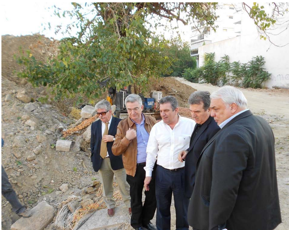
Επίσκεψη στο Ρέμα της Εσχατιάς για την επιθεώρηση του έργου.
